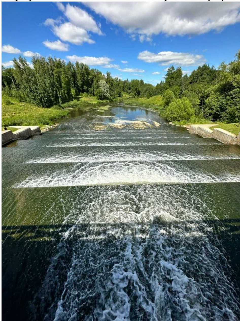
Современное фото плотины №3
