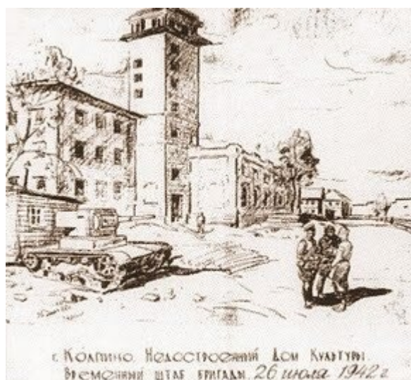
Город Колпино. Недостроенный Дом Культуры. Временный штаб бригады. 26.07.1942г.
