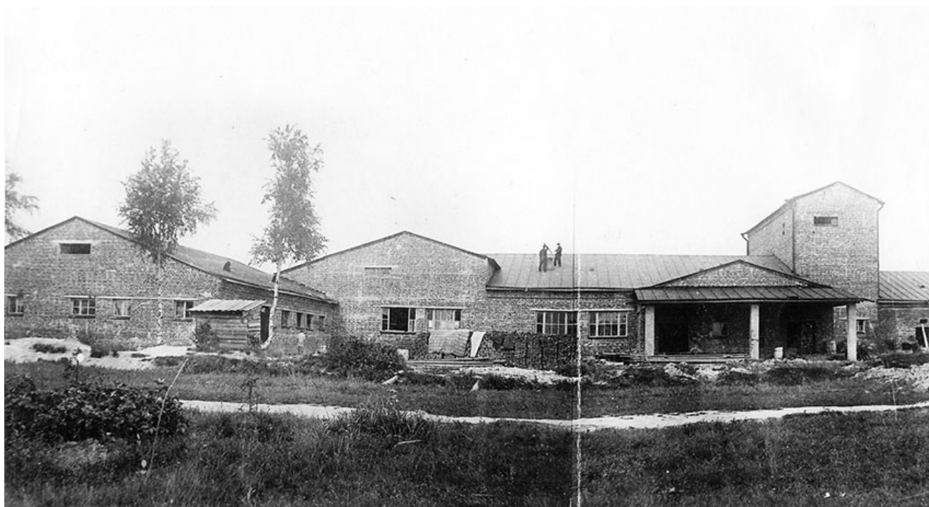
Строительство Колпинского хлебозавод Межевая улица, д. 26. Фото 1930-32 гг.
